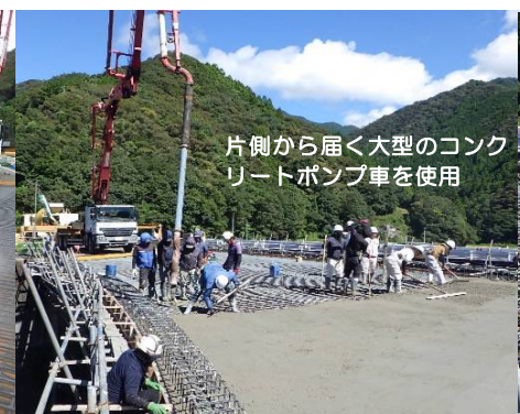
コンクリート天端仕上げ中白く見えるのは表面養生剤です。
