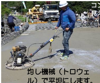
コンクリート打設状況、手順通りの施工を確認中
