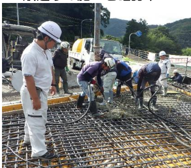
コンクリート打設状況、手順通りの施工を確認中
