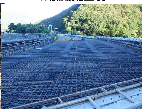
床版鉄筋組立完了
