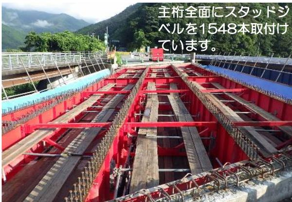
主桁全面にスタッドジベルを1548本取付けています。
