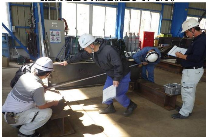
再利用する主桁のサビ落とし、スタッドジベル設置前の大事な作業です。
