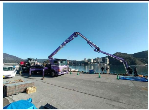
コンクリート打設はポンプ車のホースを打設箇所まで移動させて行います。潜水作業となるので、事前にしっかりと打合せをしてから作業に取り掛かります。
